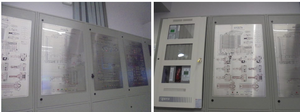
ภาพที่ 3-30 ตู้ควบคุมสัญญาณเตือนอัคคีภัย
