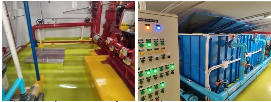
ภาพที่ 3-14 ถังสำรองน้ำใต้ดิน ฝ้ายกสูงจากพื้นและระบบกรองน้ำประปากรองสับส่งไปยังส่วนต่าง ๆ
