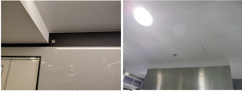
ภาพที่ 3-34 ระบบหัวกระจายน้ำดับเพลิง (sprinkler)
