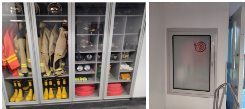
ภาพที่ 3-37 ตู้เก็บอุปกรณ์ผจญเพลิง และตู้เก็บสายฉีดน้ำดับเพลิง
