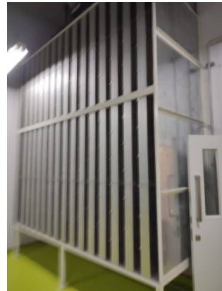
ภาพที่ 3-17 ห้องเครื่องไฟฟ้าสำรอง ติดตั้งระบบกันเสียงดังและอุปกรณ์แจ้งเตือนอัคคีภัยและป้องกันอัคคีภัย
