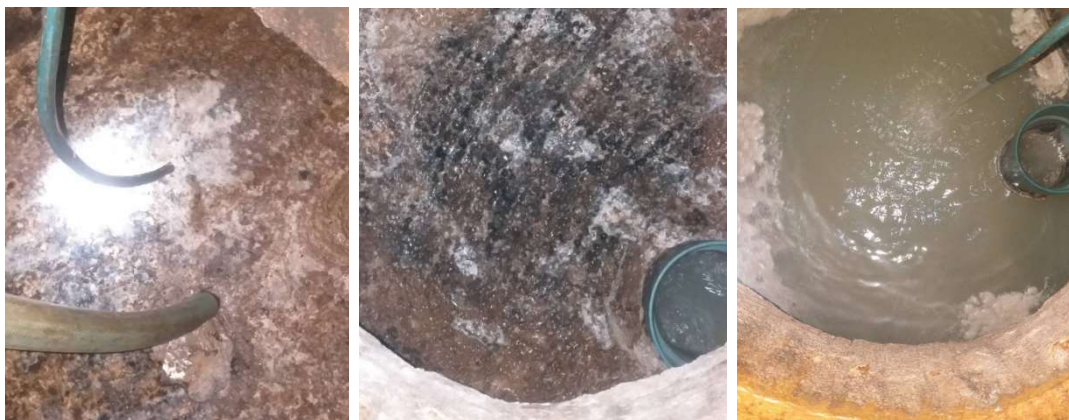
ภาพที่ 3-45 ดูดตะกอนที่บ่อพักตะกอนและตะกอนไขมันที่บ่อดักไขมัน
