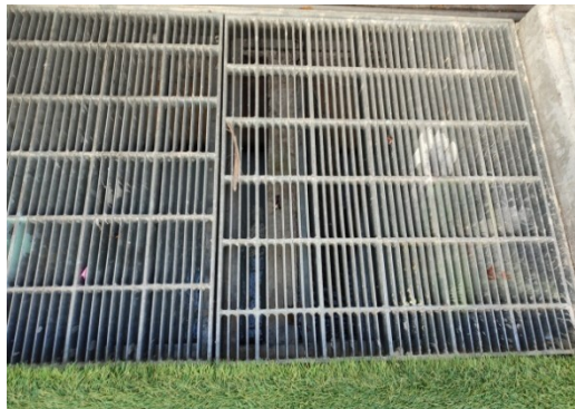
ภาพที่ 3-8 ป่อตรวจคุณภาพน้ำทิ้ง และตะแกรงดักขยะ
