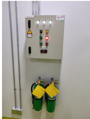
ภาพที่ 3-17 ห้องเครื่องไฟฟ้าสำรอง ติดตั้งระบบกันเสียงดังและอุปกรณ์แจ้งเตือนอัคคีภัยและป้องกันอัคคีภัย
