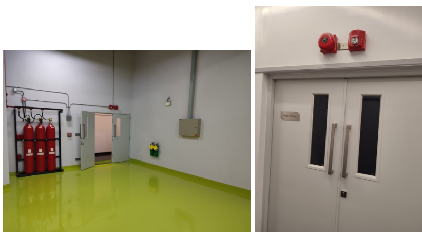
ภาพที่ 3-16 ห้องหม้อแปลงไฟฟ้าติดตั้งอุปกรณ์แจ้งเหตุเพลิงไหม้และอุปกรณ์ดับเพลิง
