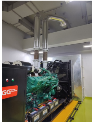
ภาพที่ 3-17 ห้องเครื่องไฟฟ้าสำรอง ติดตั้งระบบกันเสียงดังและอุปกรณ์แจ้งเตือนอัคคีภัยและป้องกันอัคคีภัย
